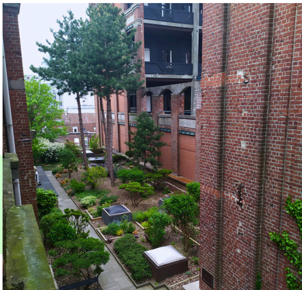
Terrasse : avant les travaux
