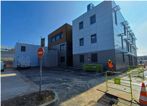
Mars 2025 : le bâtiment "Marguerite Thibert" en travaux
